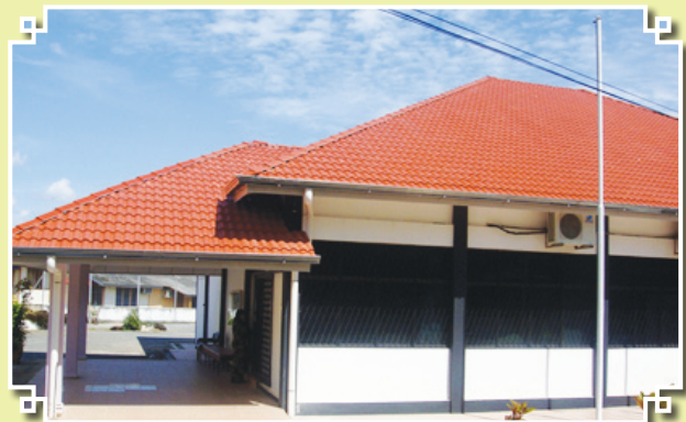
Kerja-Kerja Menggantikan Atap Bumbung di Mahkamah Majistret Kuala Nerang, Kedah
