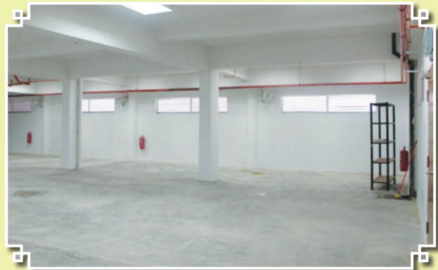
Kerja-Kerja Membina Bangunan Untuk Bilik Fail Baru di Mahkamah Sesyen Kota Tinggi, Johor
