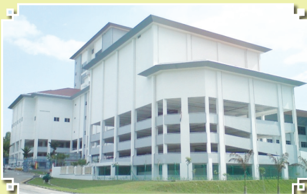
Bangunan Tambahan Mahkamah Sesyen/ Majistret Shah Alam, Selangor. (6 Bilik Bicara)
