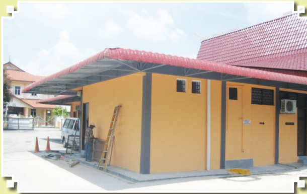
Kerja-Kerja Mengecat Bangunan Luar di Mahkamah Majistret JAWI, Pulau Pinang
