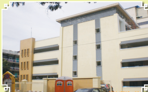
Tempat Letak Kereta Bertingkat di Kompleks Mahkamah Petaling Jaya, Selangor.
