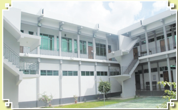
Kerja-Kerja Mengecat Bangunan Luar dan Pagar di Mahkamah Sibu, Sarawak.
