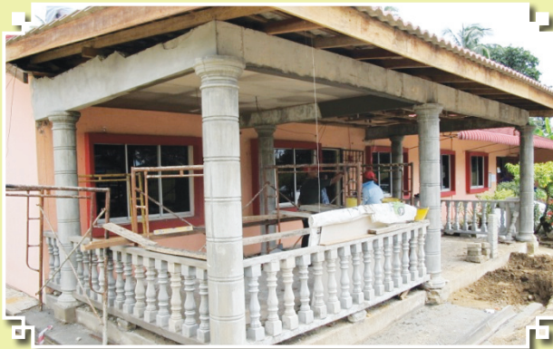
Kerja-Kerja Membesarkan Ruang Pejabat, Kaunter Pendaftaran dan Porch di Mahkamah Bachok, Kelantan.
